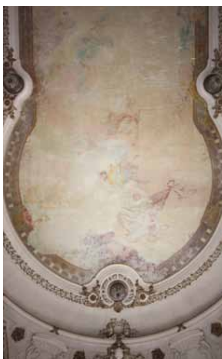
La restauration du plafond peint a été un véritable défi: d'abord pour stopper les dégradations de la toile, puis pour procéder à des retouches picturales.
